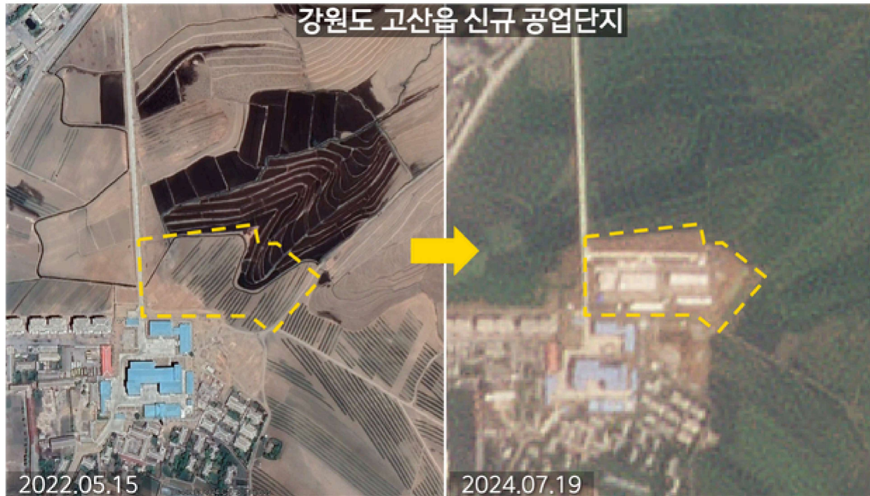
북한 강원도 고산읍의 황무지에 조성된 공장 부지. 공사가 시작된 이후 건물 공사가 진행되고 있는 모습이 식별된다. /Google Earth(좌), Planet Labs(우)
