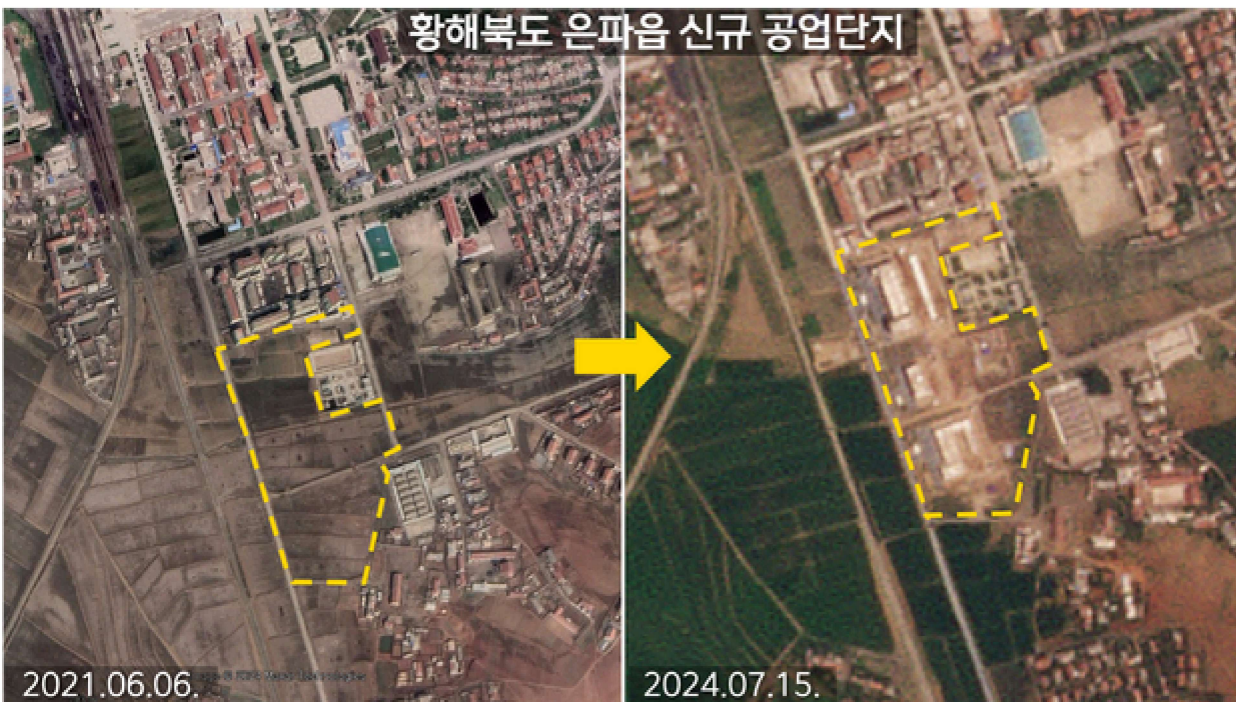
북한 황해북도 은파읍에 조성된 공장부지에 새로운 공장(3동) 모습이 보인다. /Google Earth(좌), Planet Labs(우)
