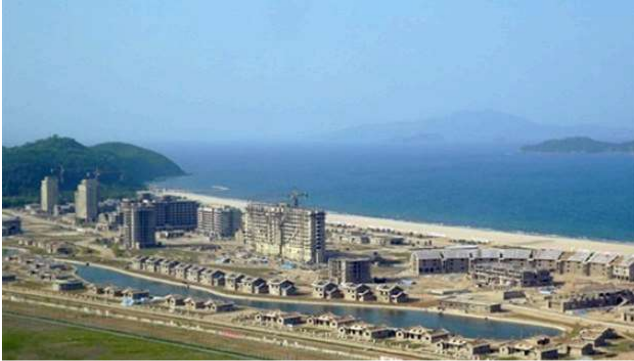
원산갈마해안관광지구 건설 현장. /연합뉴스
