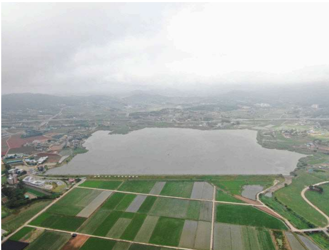
서산 잠홍저수지 전경 사진
