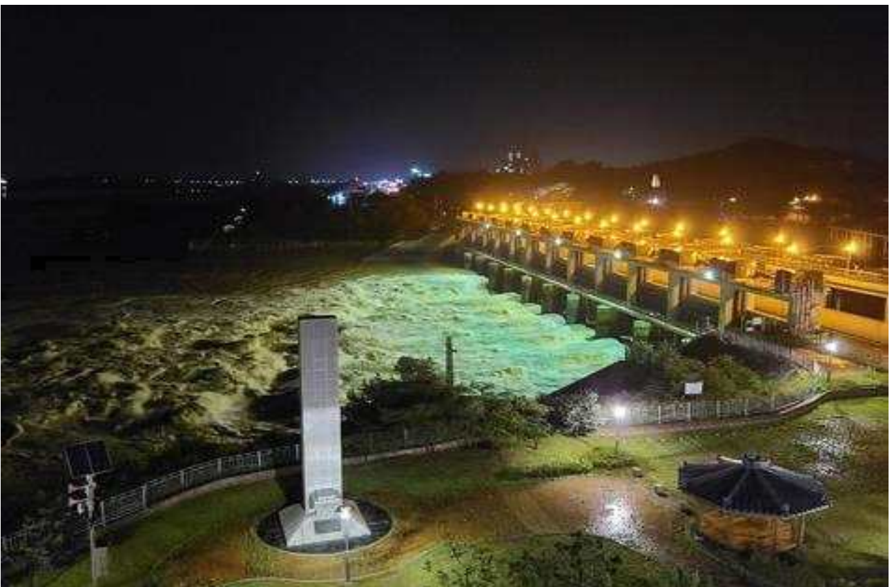
[사진2] 구배수갑문 방류전경
