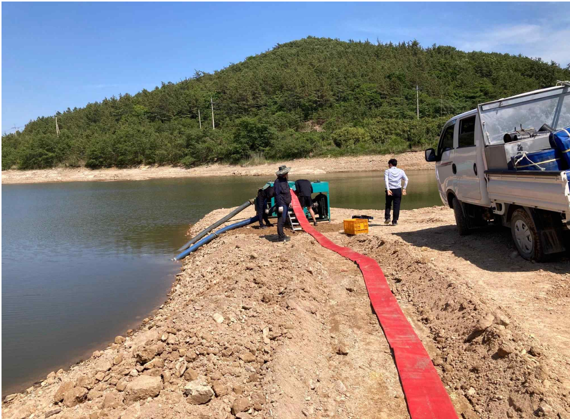
[봉암저수지 양수저류용 2단양수시설 설치]
