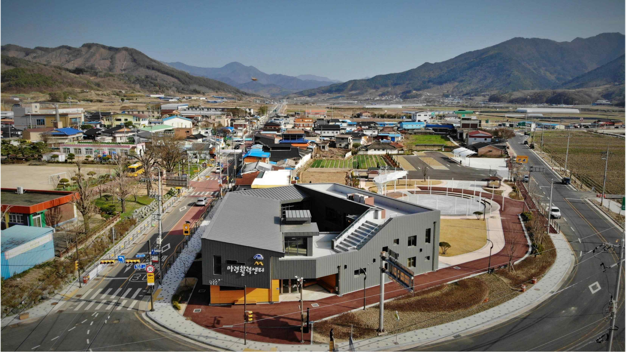
(마령활력센터) 면소재지 입구에 위치해 있으며 마령면을 지나는 모든 버스가 정차하는 버스정류장이자 휴식공간이며 문화 활동이 활발하게 이뤄지는 누구에게나 열린 공간
