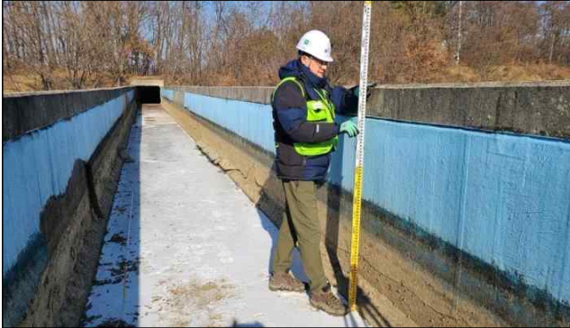
수로교 상부 외관조사
