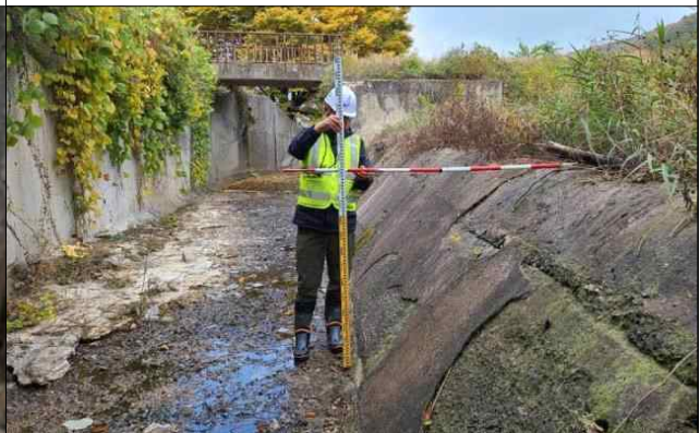
저수지 물넘이 외관조사
