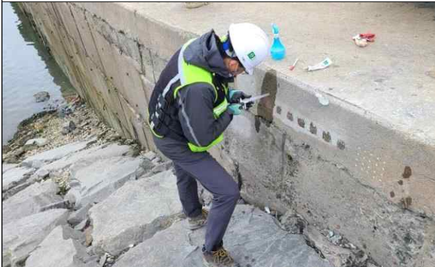
물양장 콘크리트 반발경도 시험
