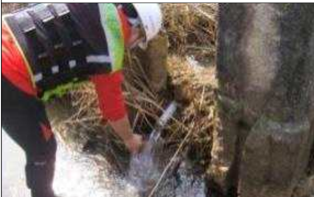
저수지 침투수 유출량 측정
