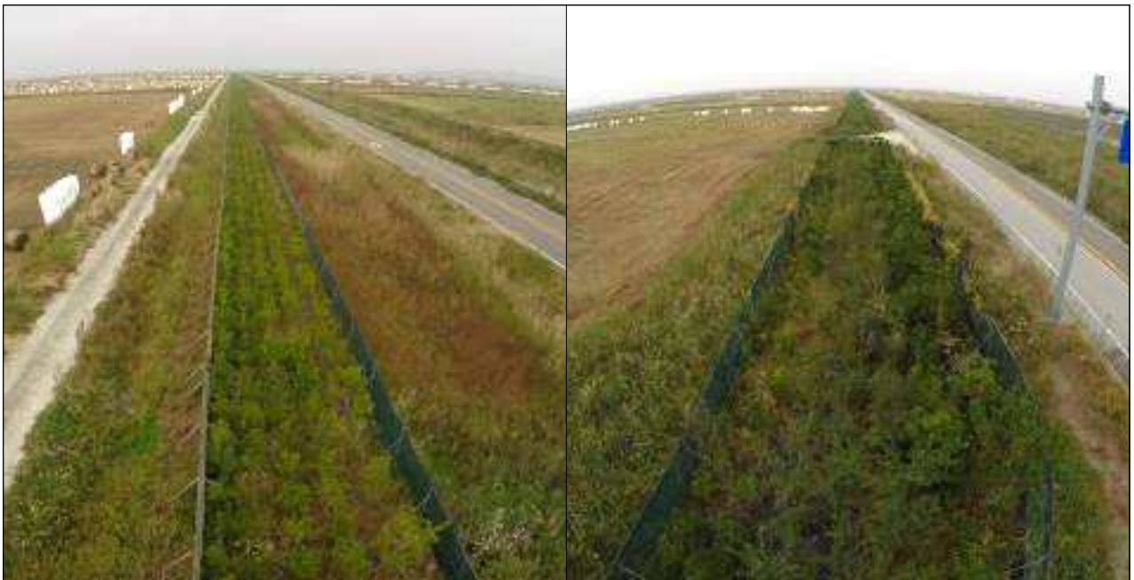
[새만금 농생명용지 5공구 방풍림 조성 전경]
