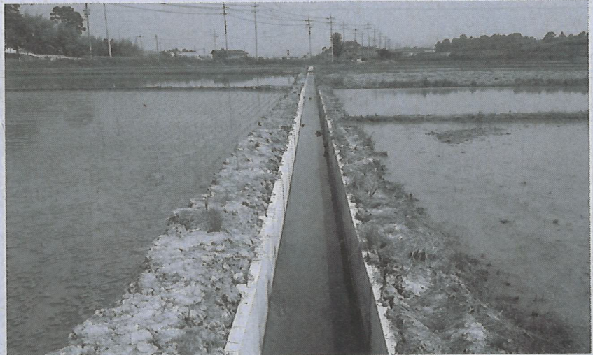
정읍시 북면 장학배수로 수로관 설치 준공.
