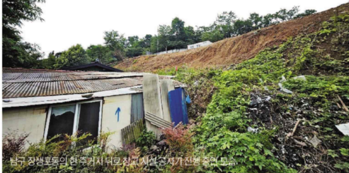
남구 장생포동의 한 주거지 바로 참고시설 부지 건설 중인 모습
