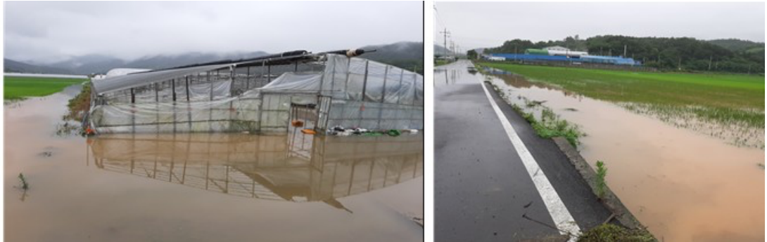
죽산지구 침수피해 현황
