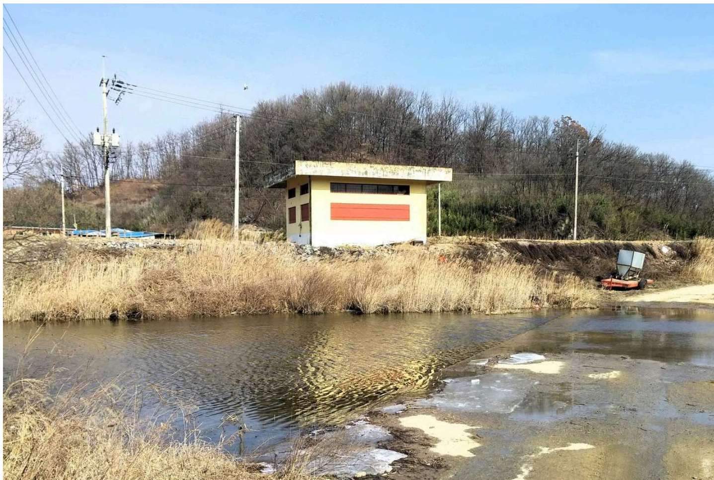
경북 상주에 위치한 이안 지하수댐의 교촌집수정 전경
