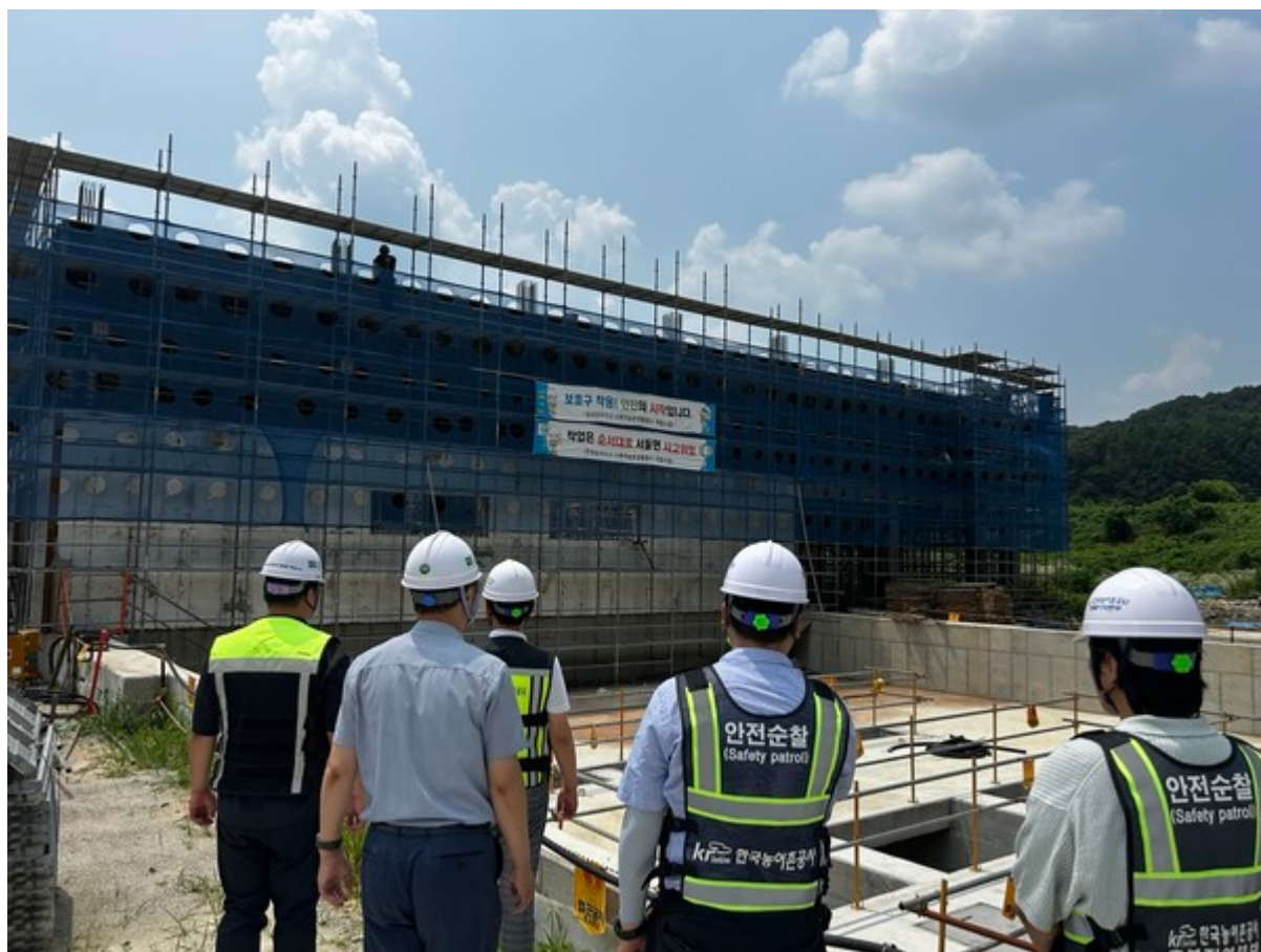
양성감곡 다목적농촌용수개발사업 공사현장 점검 모습 (사진 제공=한국농어촌공사 충북지역본부)
