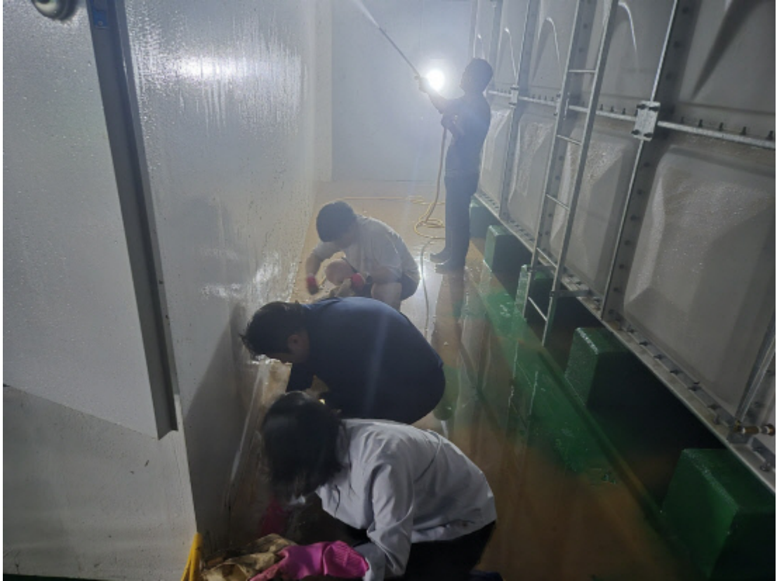
농어촌공사 진주산청지사가 산청군 신안면 일대에 신속한 피해 복구를 위하여 직원 20여 명이 함께 침수된 지하층의 물을 퍼내는 등 복구작업에 함께했다. 사진=농어촌공사 진주산청지사
