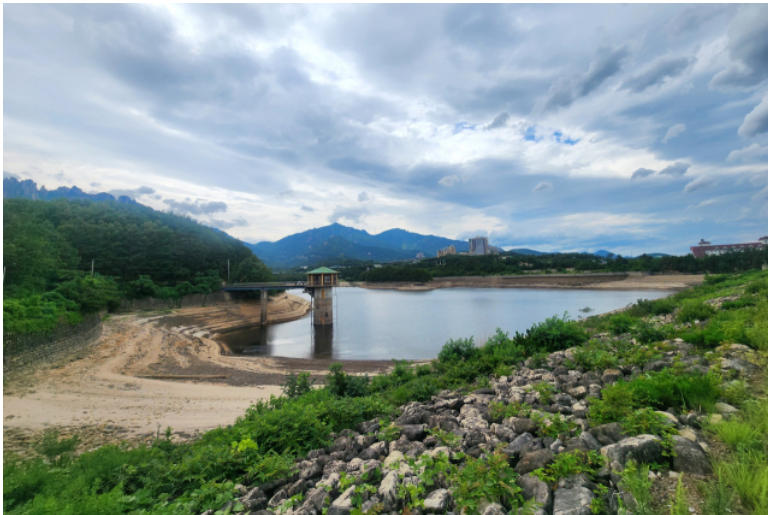
◇최근 계속되는 마른장마에 고성군 토성면 원암저수지의 저수율은 25.3%로 평년대비 39.4%까지 떨어졌다.
