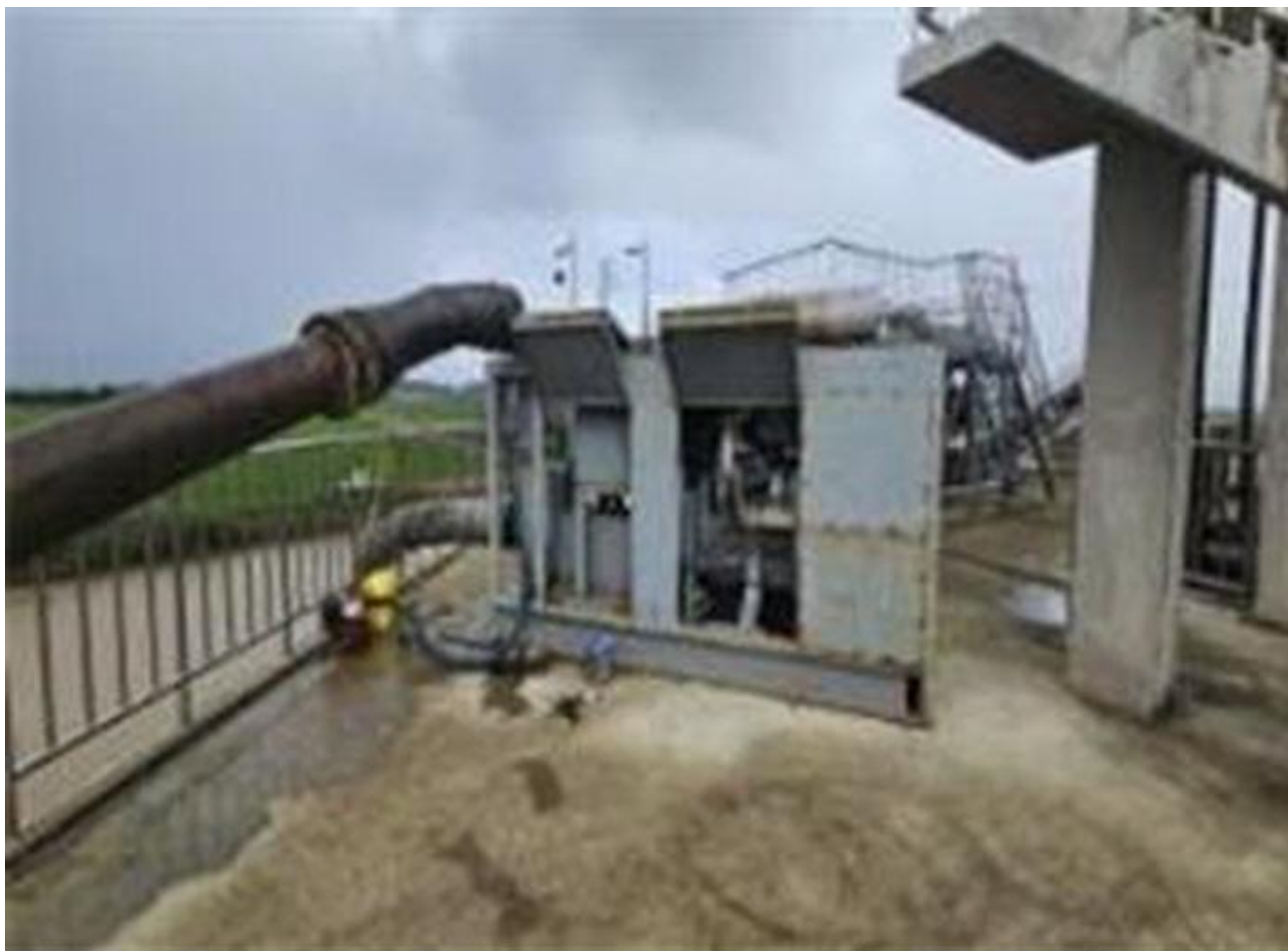
(배수작업) 엔진펌프 설치
