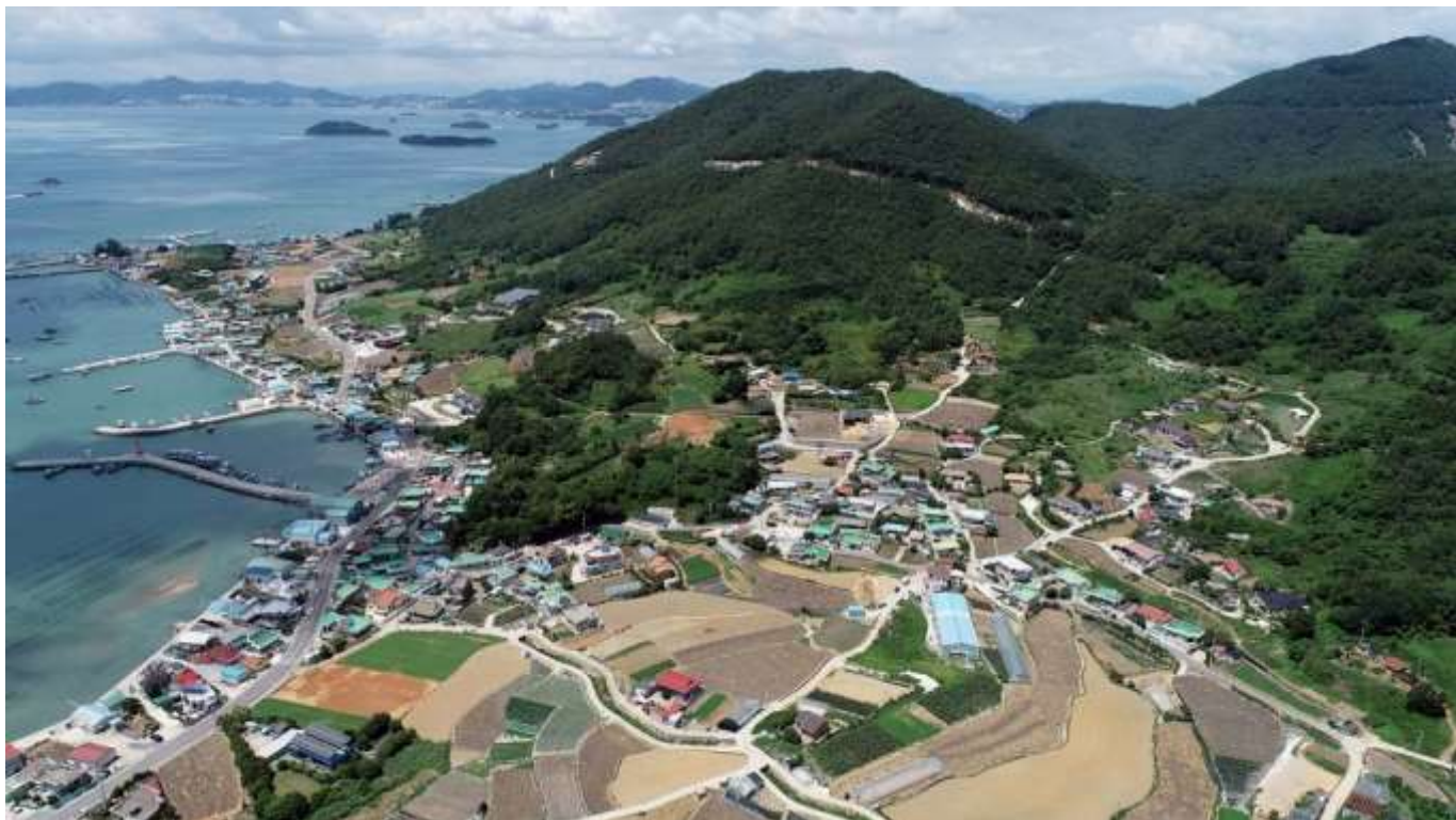
전남 여수시 금천항 어촌뉴딜300사업 대상지 전경/사진제공=농어촌공사 전남본부
