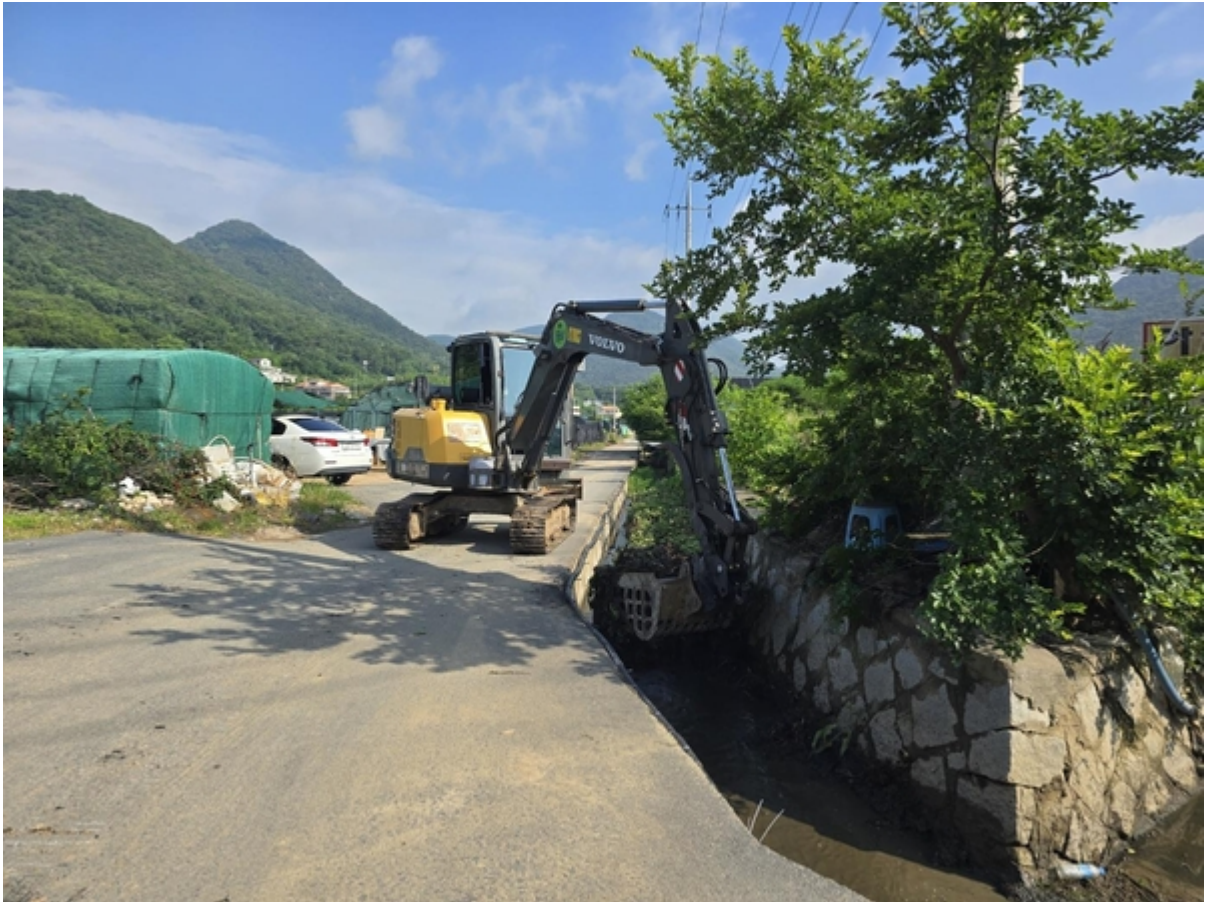
▲ 용·배수로 퇴적물 제거 작업 모습 /한국농어촌공사 김해양산부산지사
