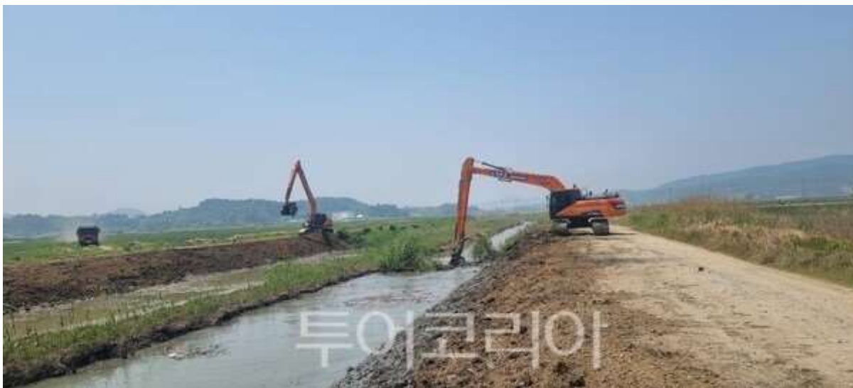
배수로 정비사업. /사진-한국농어촌공사 전남지역본부
