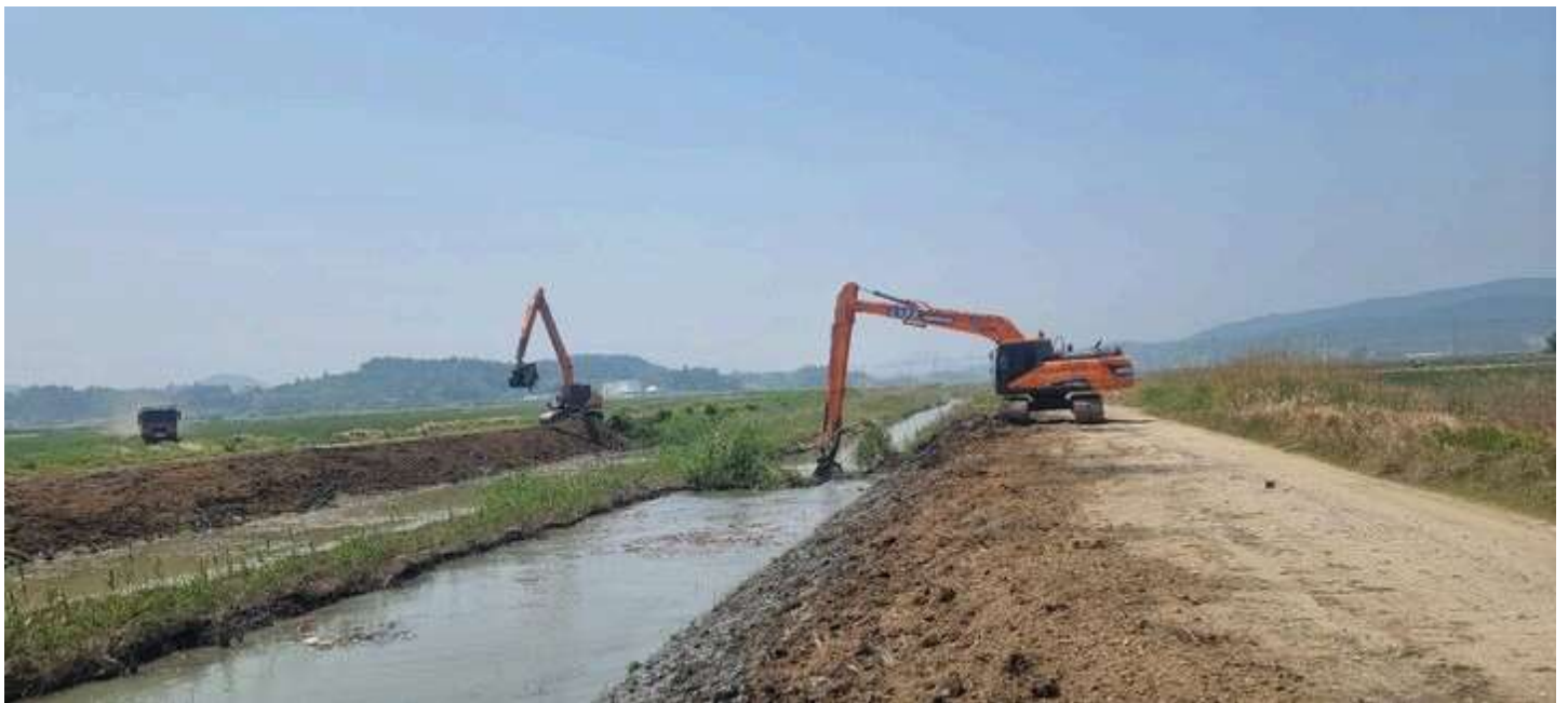
배수개선 준설 작업 모습 [사진=농어촌공사 전남본부]
