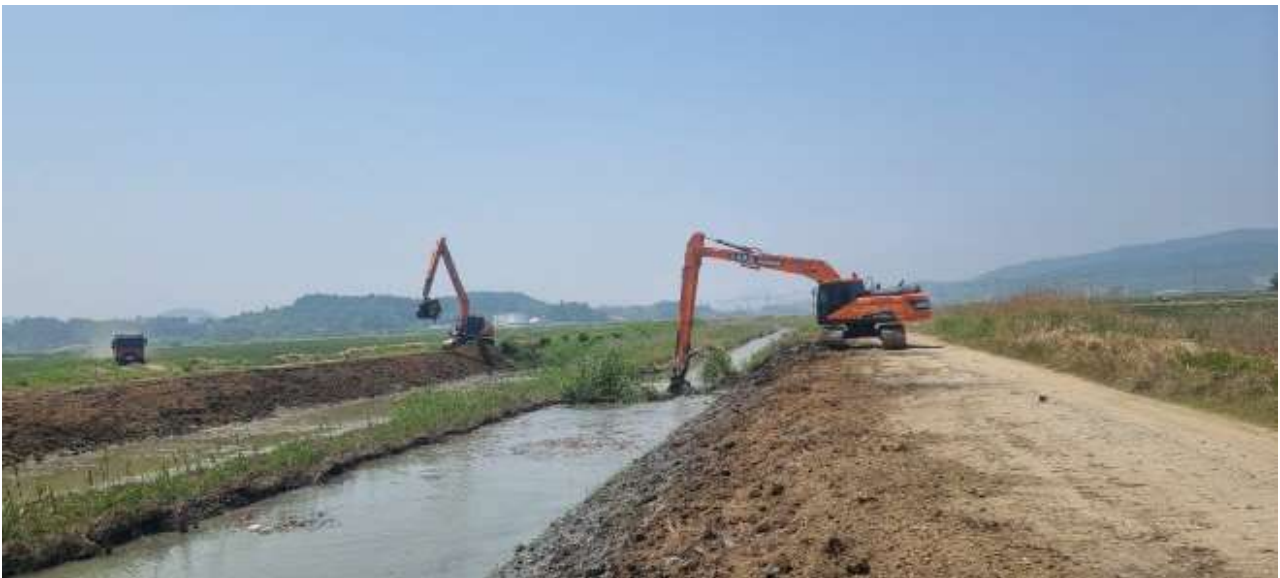
한국농어촌공사 전남본부가 전남의 한 지자체 배수로의 준설 사업 모습./농어촌공사 전남본부
