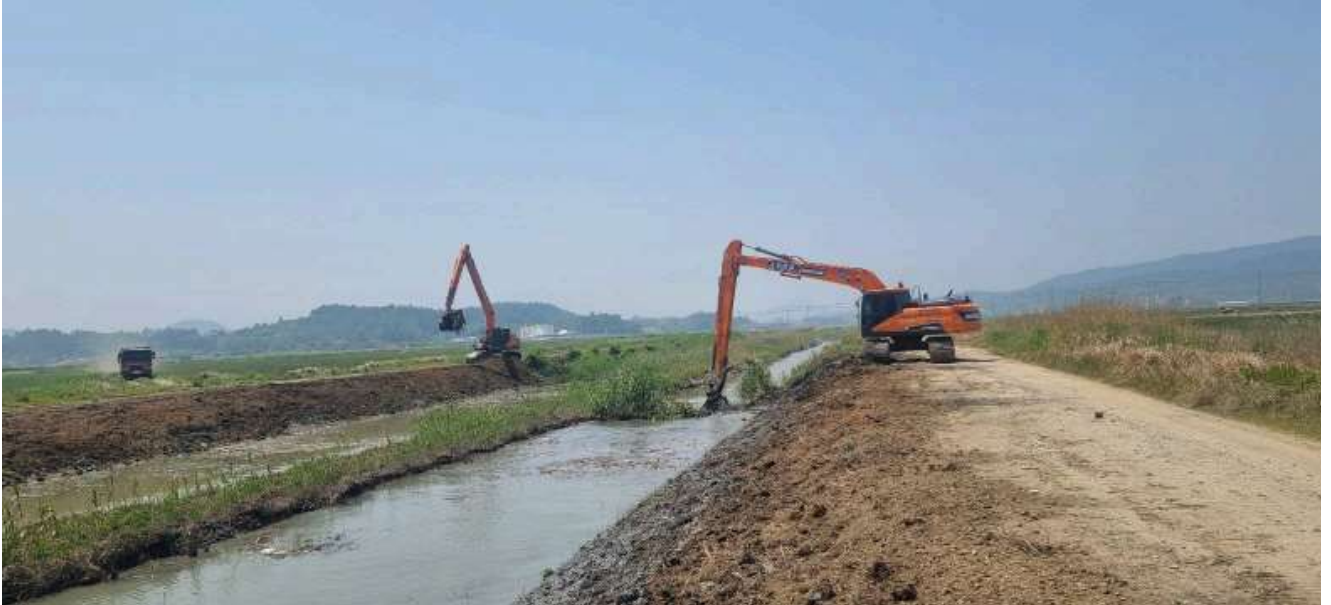
전남 관내 배수개선사업 공사 현장. 농어촌공사 전남본부 제공
