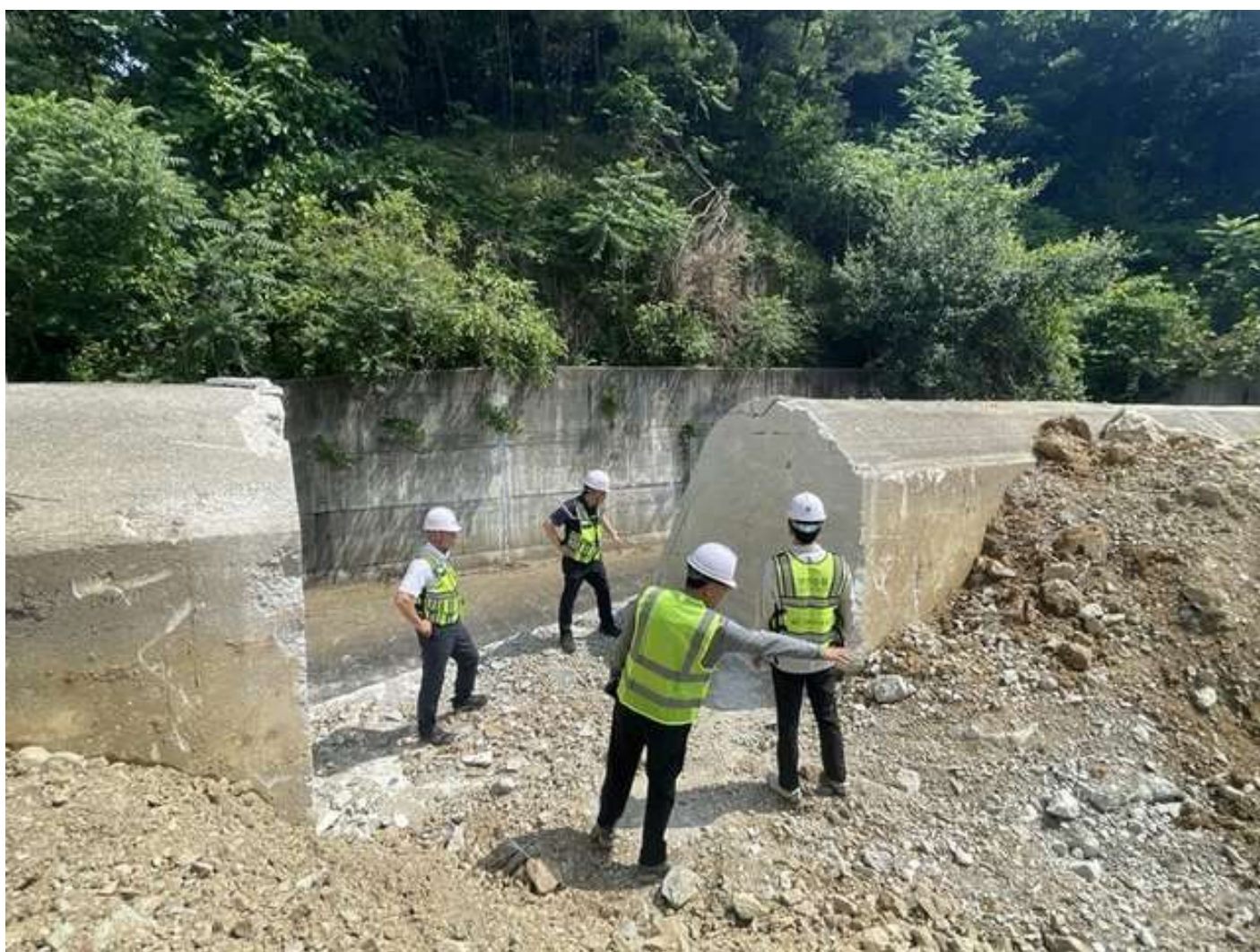
▲ 한국농어촌공사 홍천춘천지사가 본격적인 장마와 태풍 등 여름철 자연재해 발생에 대비해 최근 지역 내 시설물을 점검했다.
