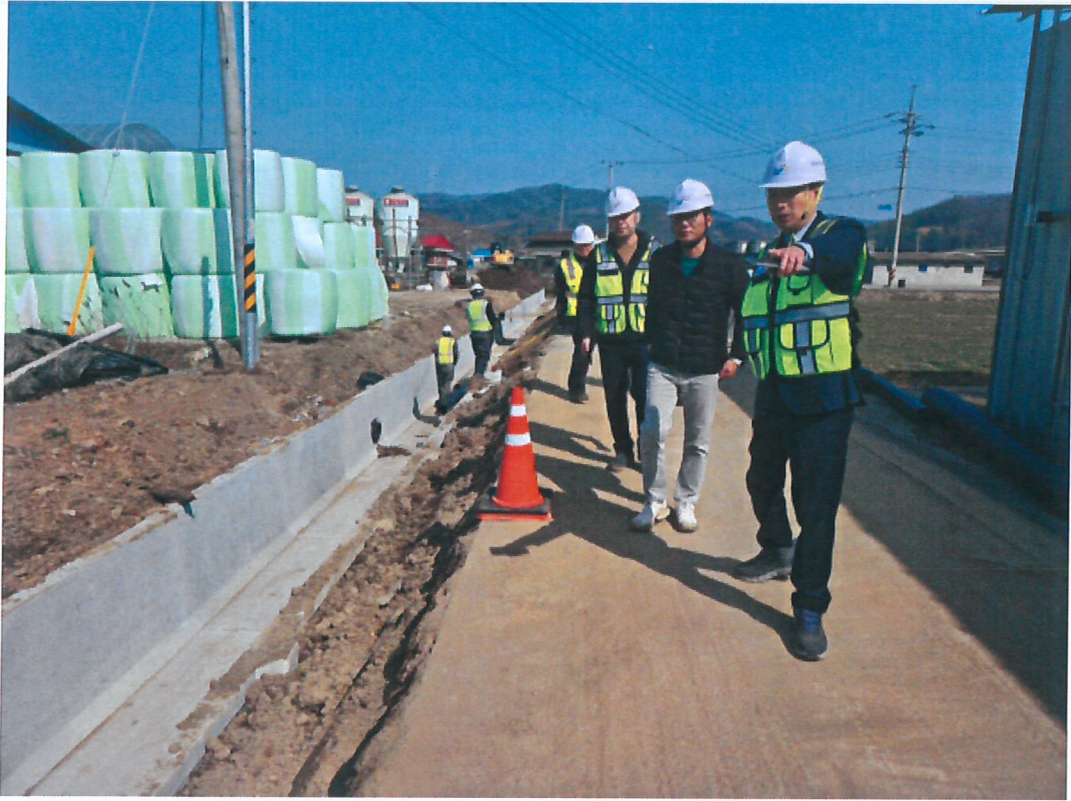
공주시사, 건설현장 안전·보건 점검 진행 모습
