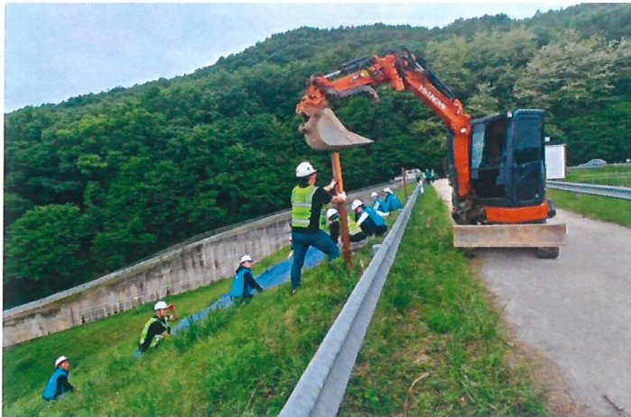
한국농어촌공사 공주시사가 올 여름 우천 재해대비 저수지 대상으로 비상대처 응급복구작업 현장 모습.
