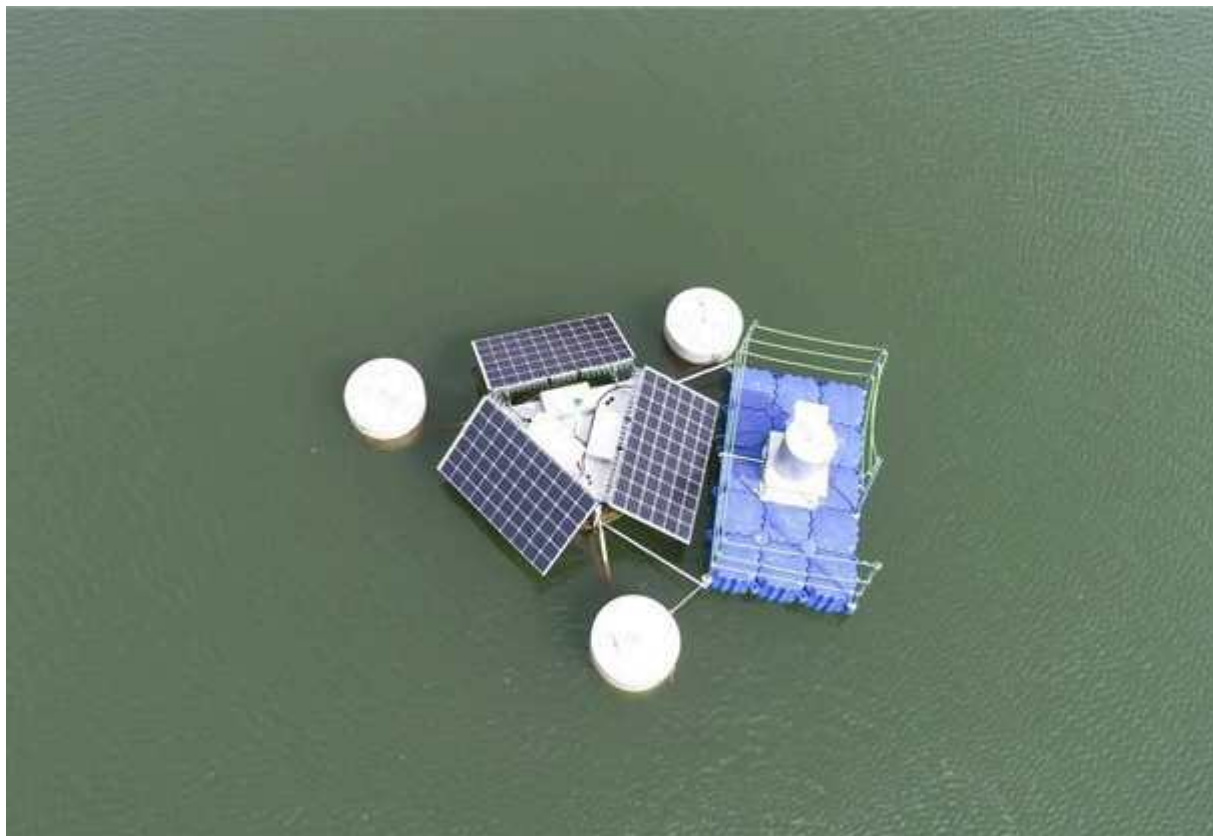
경남 거창군 신원저수지에 태양광 물순환장치와 연동된 수처리제 자동살포 수질정화시스템 [사진=한국농어촌공사 경남지역본부] 2025.03.10
