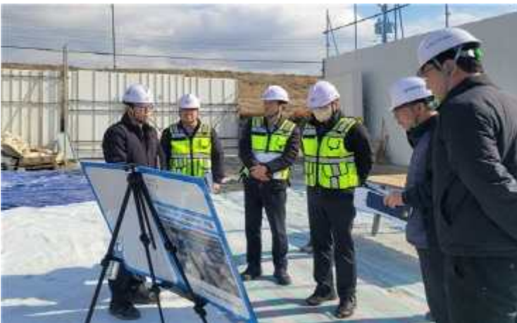
경남지역본부장 안전관리센터 현장안전점검 /농공경남본부
