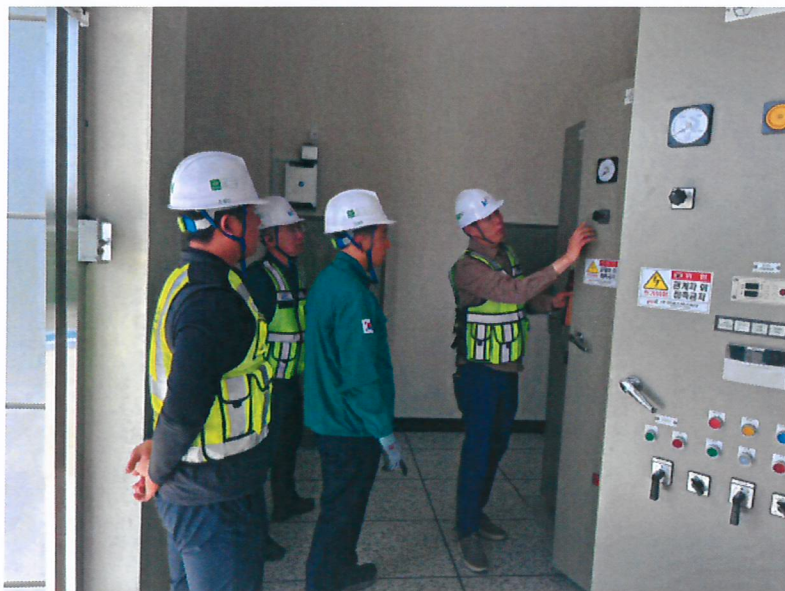
배수장 점검 사진=공주시사
