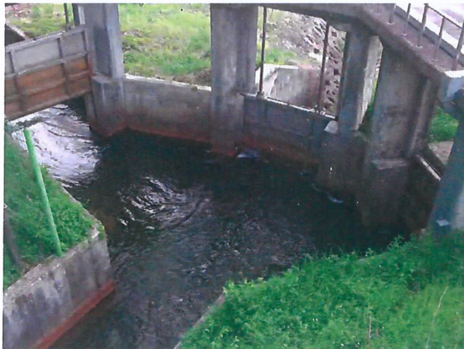
한국농어촌공사 공주시사의 본격적인 영농기 농업용수 급수공급에 따라 계통저수지 제빙 수문 (사진제공=공사 공주시사)
