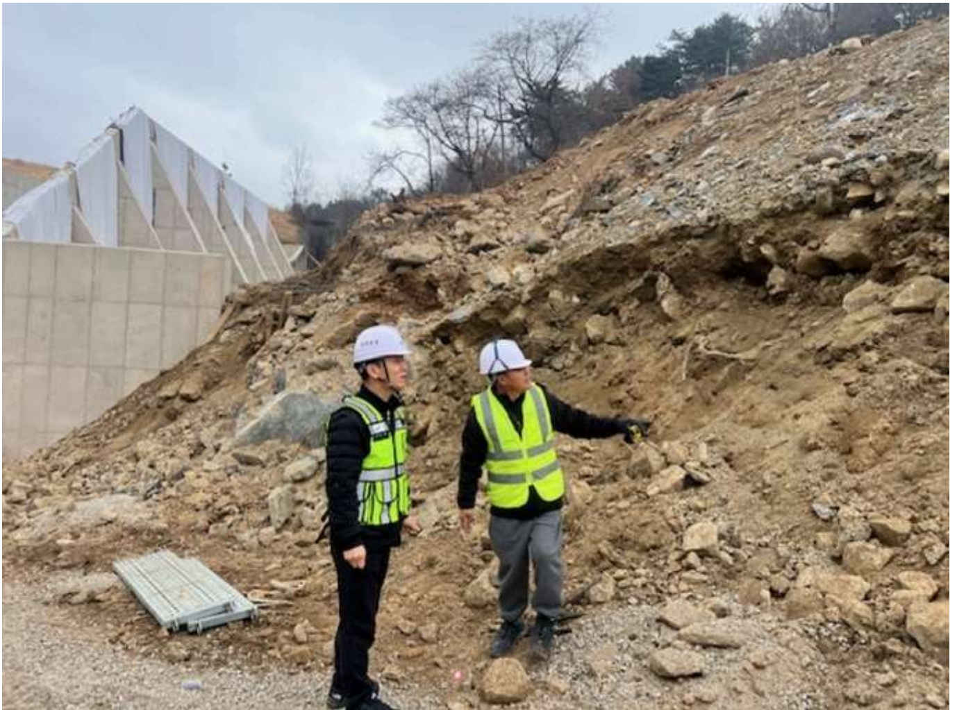
토공사 절토면 해빙기 안전점검 장면/사진제공=농어촌공사
