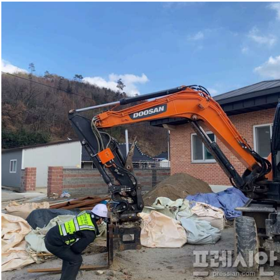
▲전남지역본부가 해빙기 건설현장 안전사고 예방을 위해 이달 말까지 전남지역 내 건설현장에 대한 안전점검을 실시한다◎전남본부
